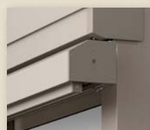
収納ボックスを固定し完成
